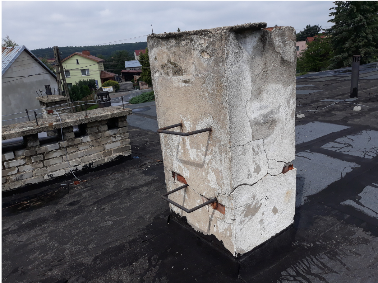
Zdj. nr 4 kominy wentylacyjne i dymowy na budynku internatu.
