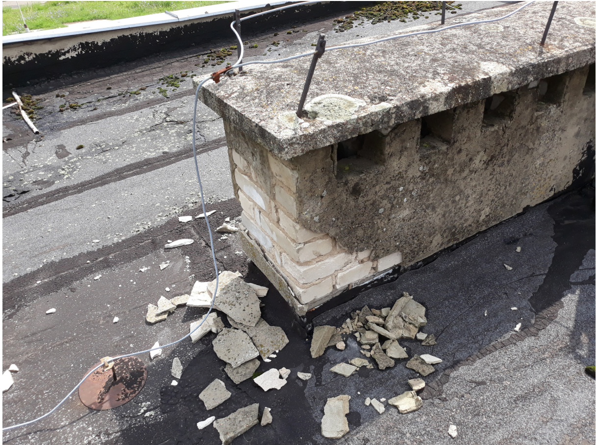
Zdj. nr 6 komin wentylacyjny na budynku łącznika.
