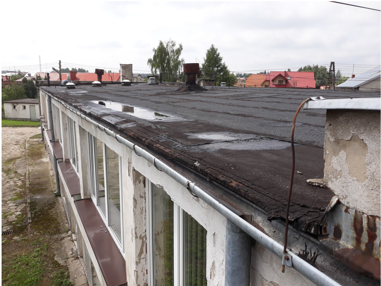
Zdj. nr 5 dach na budynku internatu.
