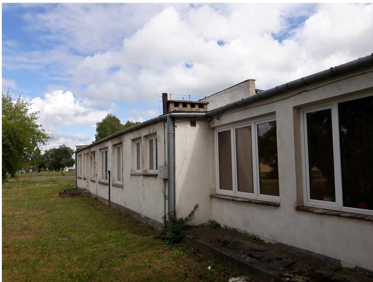
Zdj. nr 3 budynek łącznika od strony północnej.
