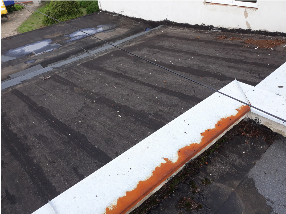
Zdj. nr 9 pokrycie papą budynek łącznika
