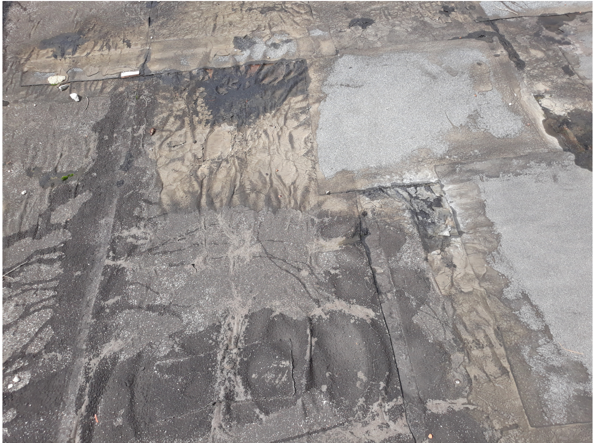
Zdj. nr 8 pokrycie papą budynek internatu.
