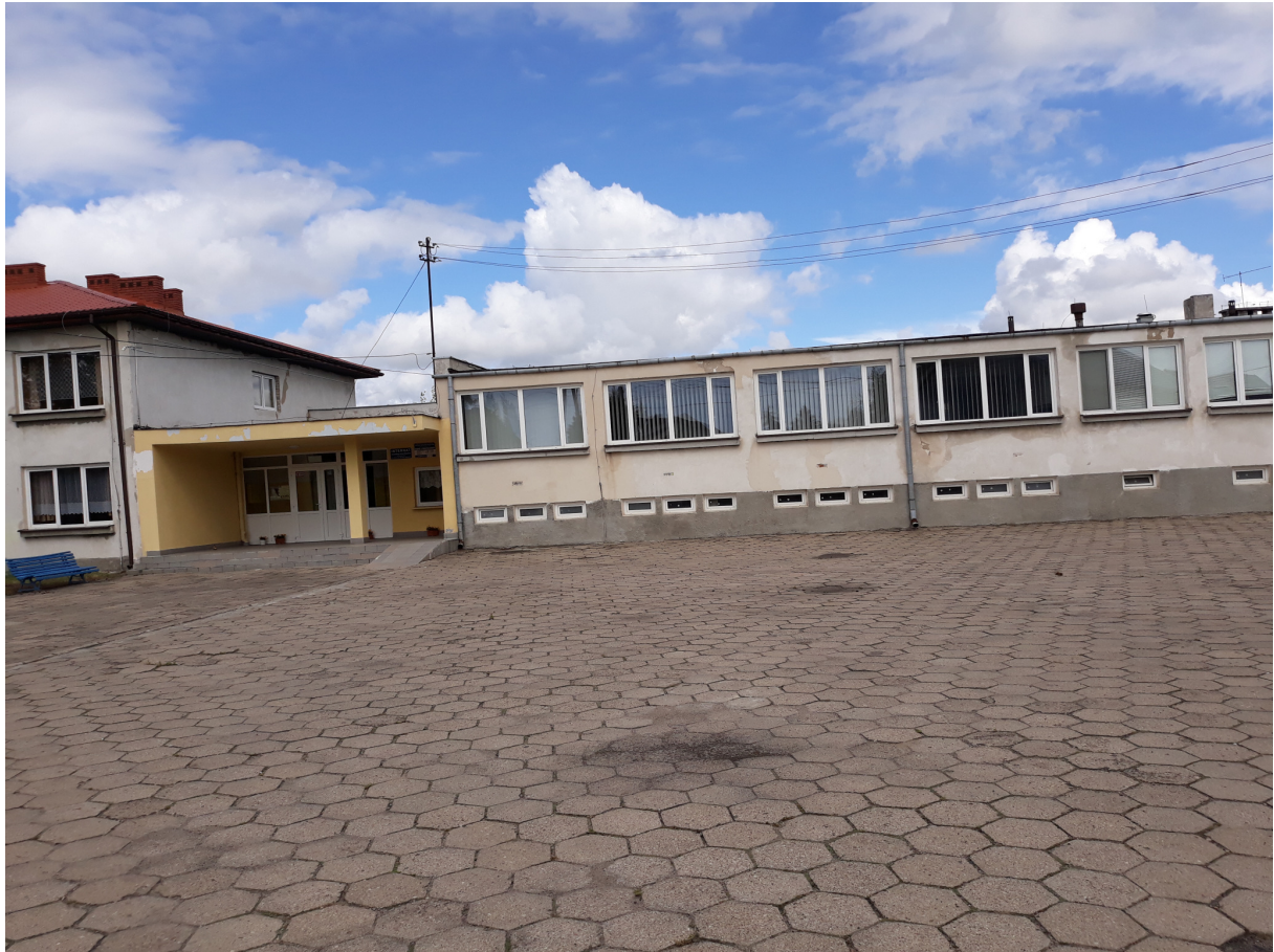
Zdj. nr 1 budynek internatu od strony zachodniej
